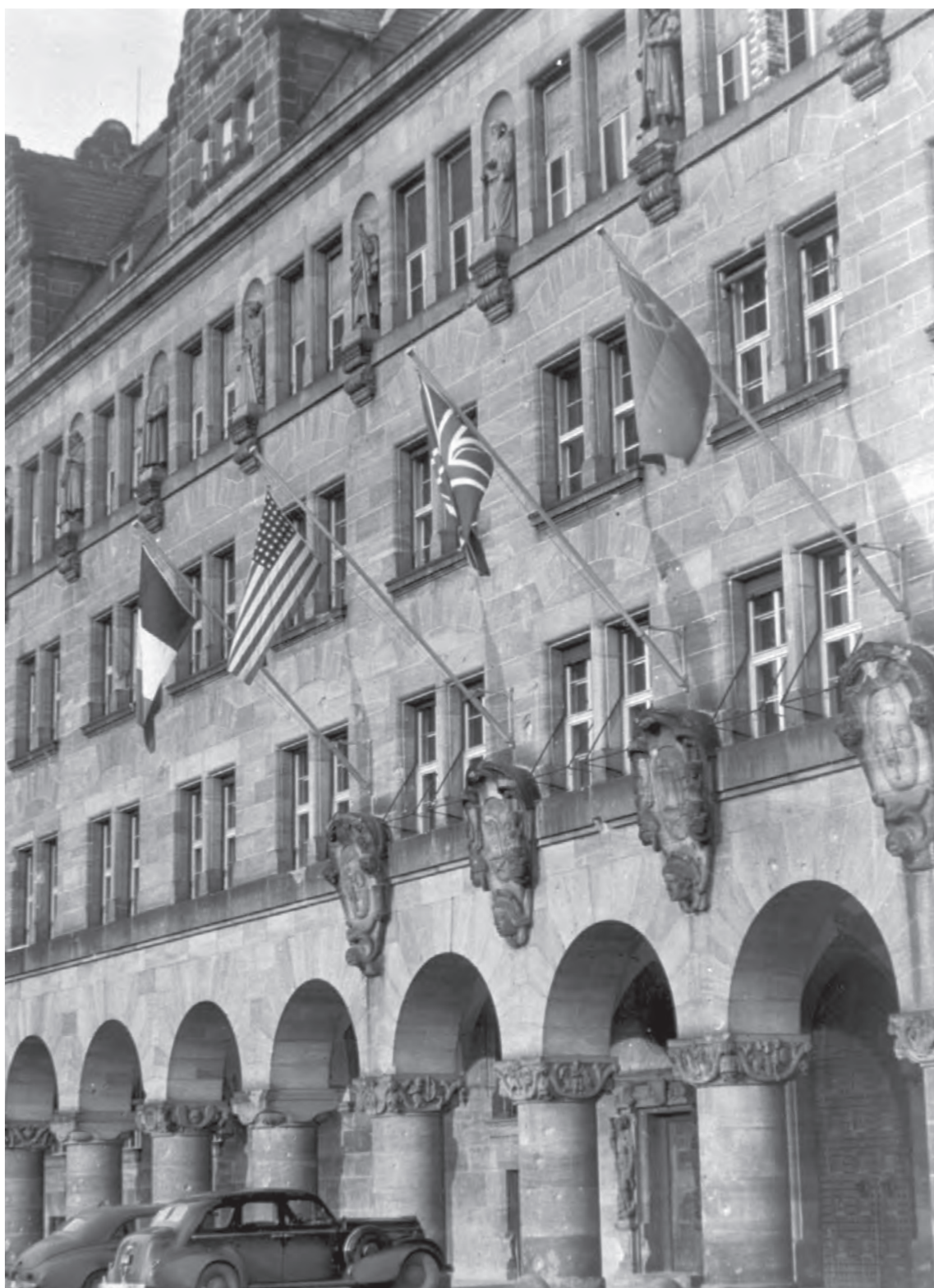
Здание Дворца Юстиции, где проходил Нюрнбергский процесс. Нюрнберг. 1945. Фотограф Е. А. Халдей
