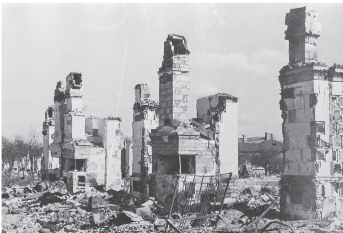
Вид на разрушенные жилые дома в Минске. 1941
