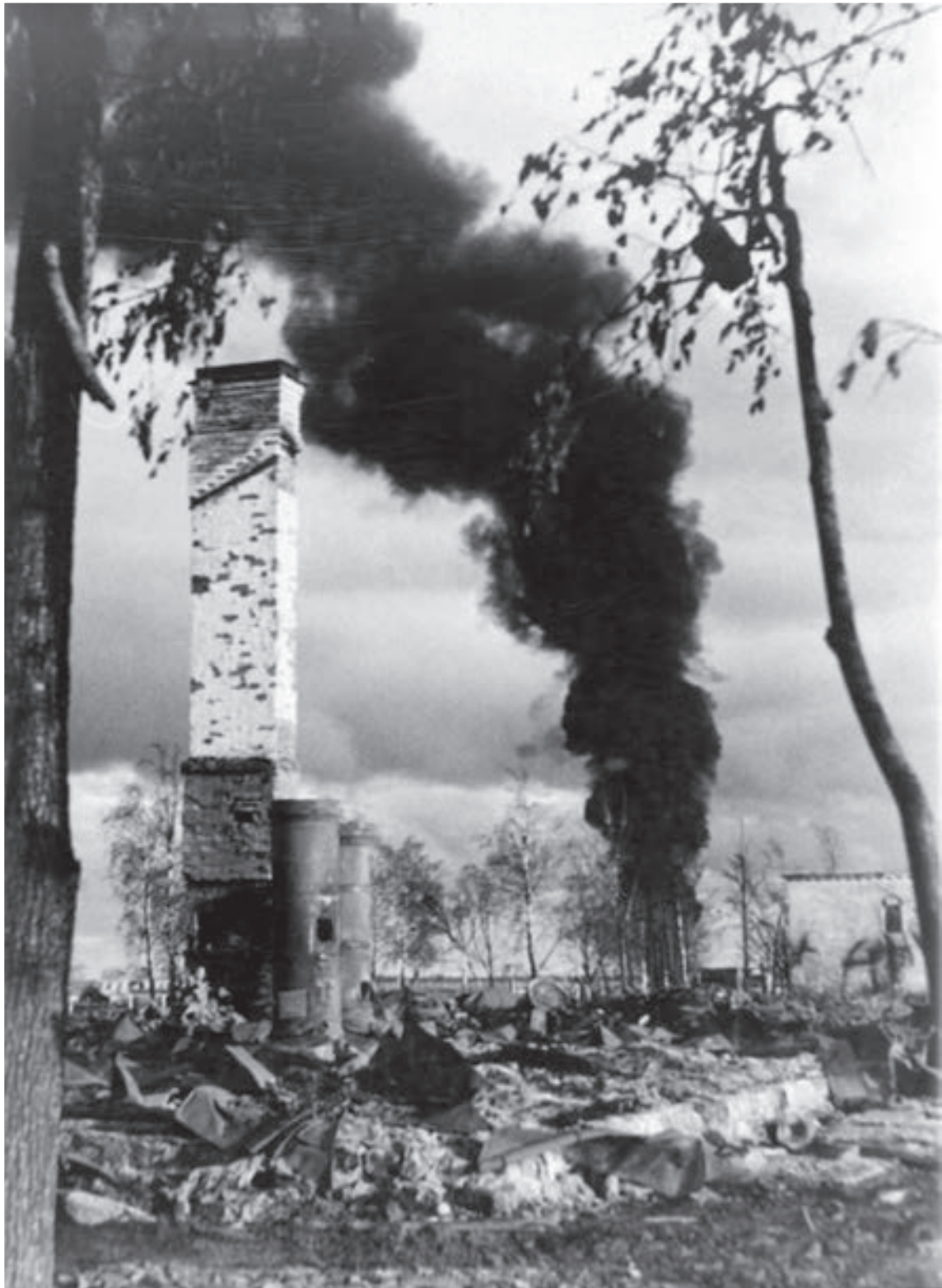
Разрушенная белорусская деревня. 1941 г. Фотограф Шплек
