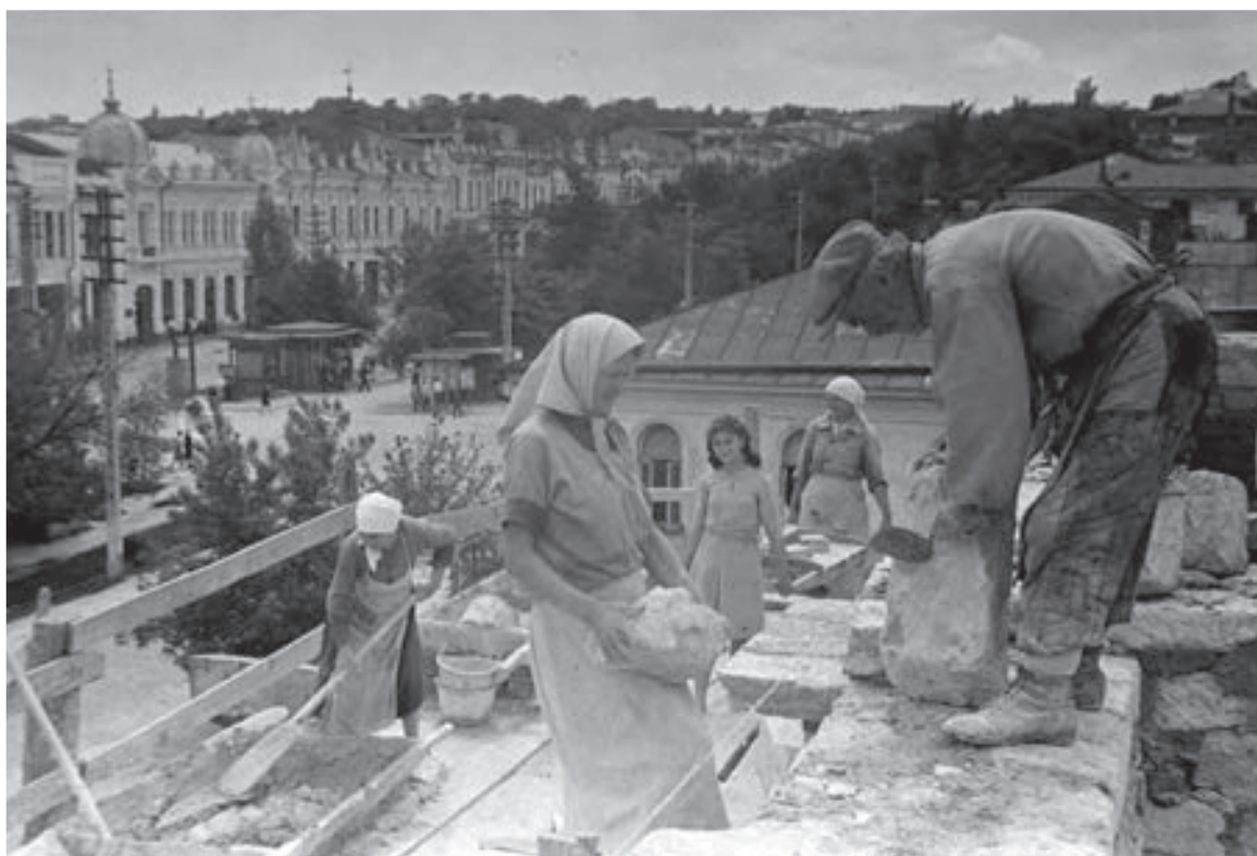
Жители г. Ставрополя ведут работы по восстановлению разрушенного в годы Великой Отечественной войны театра. 1944 г. Фотограф М. Грачев
