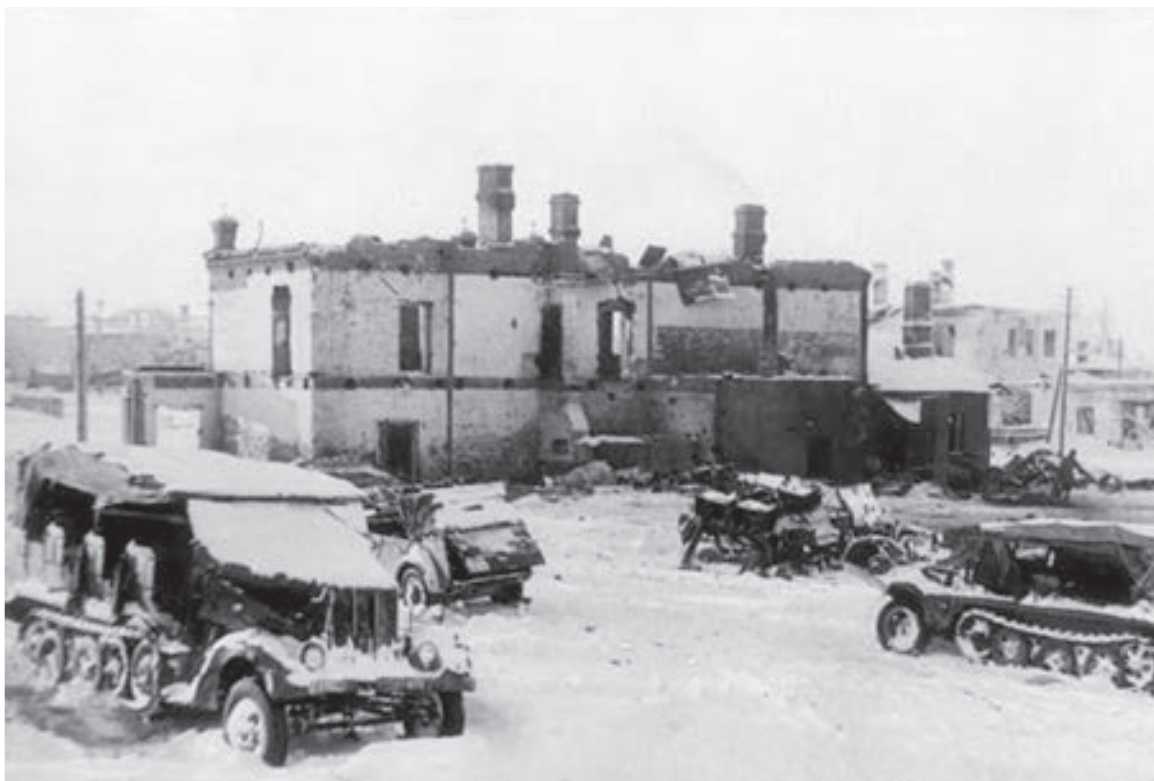
Немецкие бронемшины, брошенные при отступлении, у разрушенного Дома-музея П. И. Чайковского. Клин, Московская обл., март 1942 г. Фотограф не установлен
